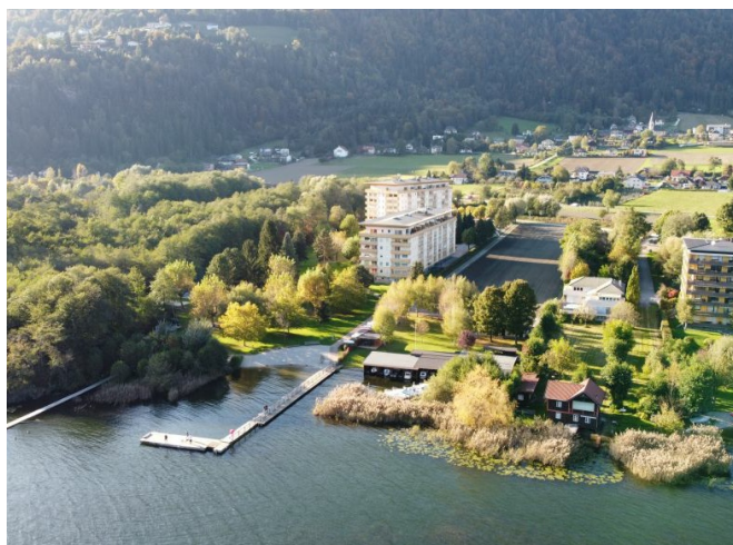
Wohnanlage vom See 2
